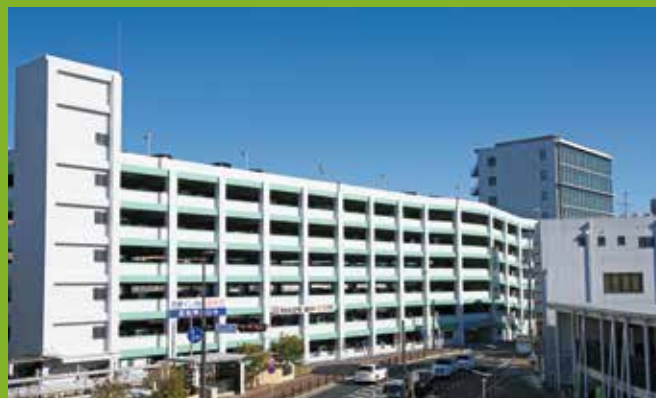
刈谷南口立体駐車場
