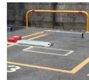
ライン工事・タイヤ止め
